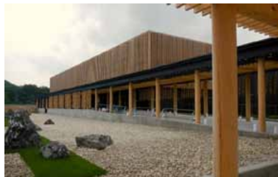
国際メディアセンターアネックス外観
